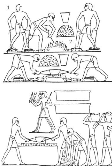
Egyptská kelímková pec na tavení mědi. 1. Muž pohánějící měchy šlapáním. 2. Pec. 3. Kelímek naplněný rudou. Malba na tumbě, Théby, kolem r. 1500 B.C.
