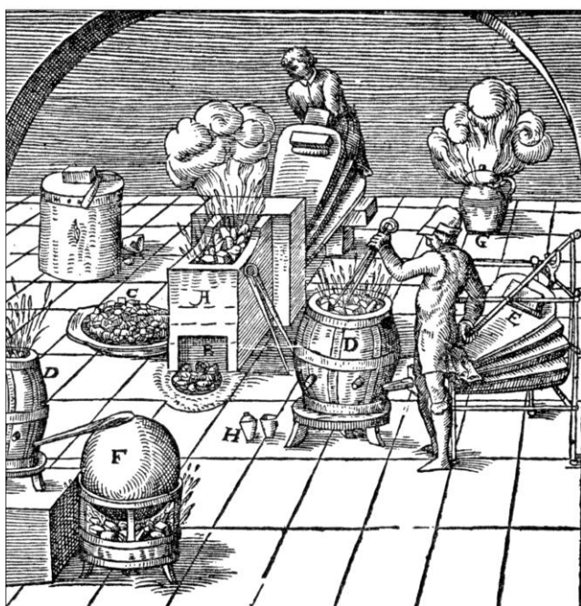
Tavení mědi. A., D. pece ke slévání měděné rudy v kelímcích (H). C. roztlučená ruda, E. měchy, F. dmychadlo páry používané místo měchů, G. příprava taviva, podle Lazara Eckera, 1574.
